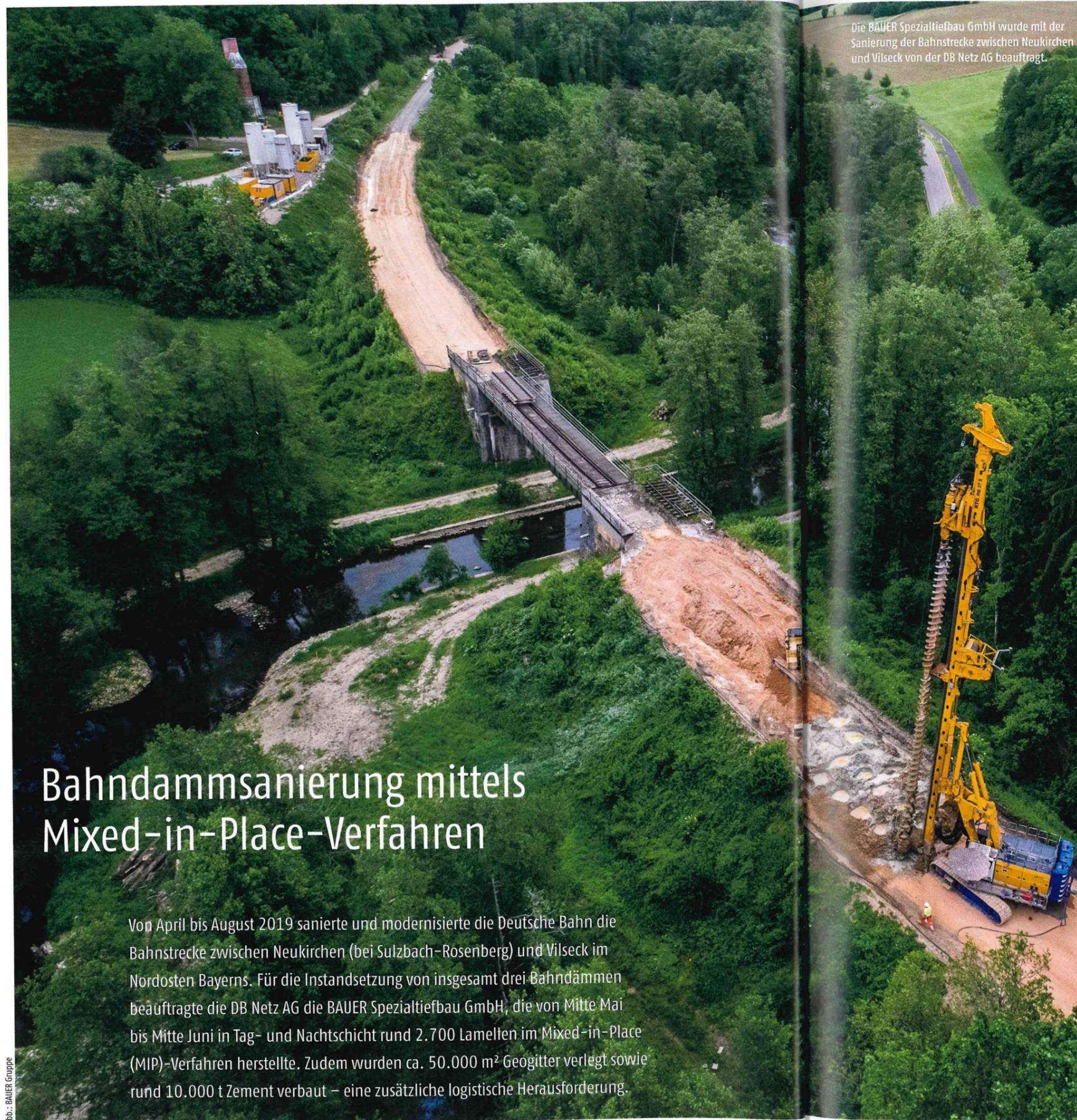
Die BAUER Spezialtiefbau GmbH wurde mit der Sanierung der Bahnstrecke zwischen Neukirchen und Vilseck von der DB Netz AG beauftragt.
