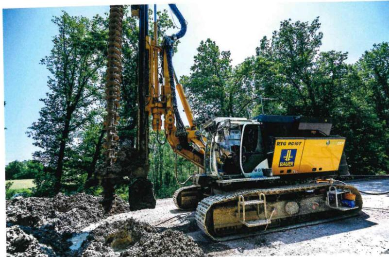
Abb. 2 – Zum Einsatz kamen zwei MIP-Bohrgeräte des Typs RG 19 mit einem Schneckendurchmesser von 370 mm und einer Bohrtiefe von maximal 12,6 m.
