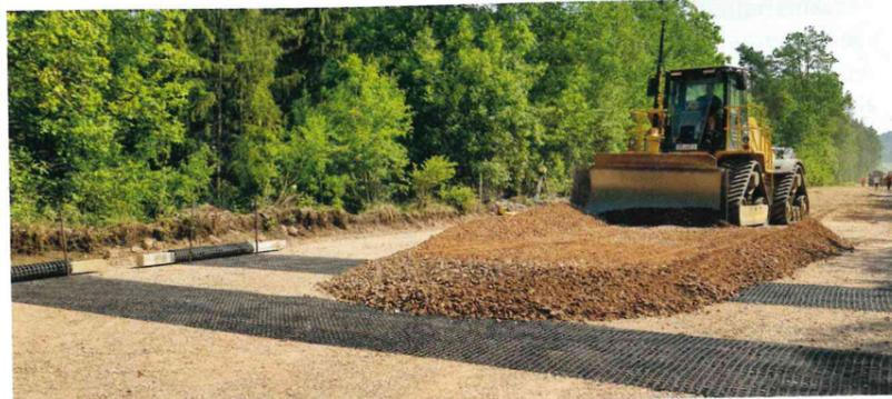
Abb. 4 – Zur Aufnahme von Zugkräften und zur besseren Lastverteilung auf die MIP-Gründungselemente wurde ca. 50.000 m<sup>2</sup> Geogitter in zwei Lagen auf den drei Dammschnitten verlegt.
