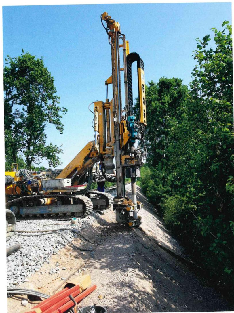
Abb. 3 – Zur Prüfung der auftretenden Verformung der Dämme wurde in jedem der drei Dammabschnitte jeweils ein Vertikalinklinometer eingebaut. Die Bohrungen wurden mit einer KLEMM KR 806 im Doppelsystem abgeteuft.
